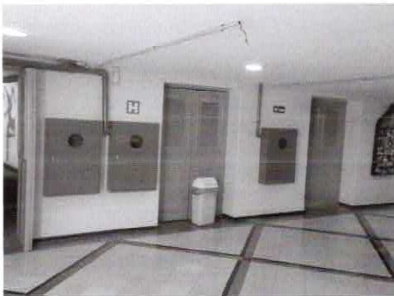
Fig.25 e 26 – Observa-se as caixas de hidrantes instaladas no American Bar do teatro e abaixo carpete anti-chamas nas paredes e piso do Teatro 04 de Setembro.
