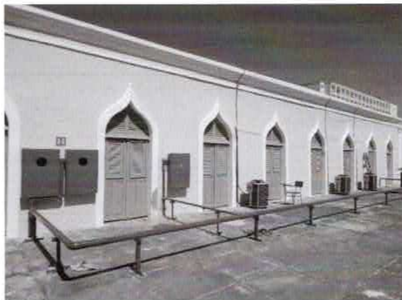
Fig.23 e 24 – Observa-se na fachada lateral externa do Teatro 04 de Setembro, acima da laje do anexo do American bar, a instalação de tubos de ferro galvanizados para interligação geral do equipamento de prevenção e combate a incêndio e abaixo tampa da caixa do reservatório d'água com capacidade para 22.000 litros.
