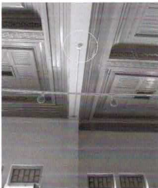
Fig.11 e 12 – Acima observa o sensor de 68°C com acionador quebra-vidro e lâmpada de alarme de incêndio instalados no salão de exposições do Clube dos Diários, e abaixo detalhe do detector de fumaça instalado neste mesmo salão.
