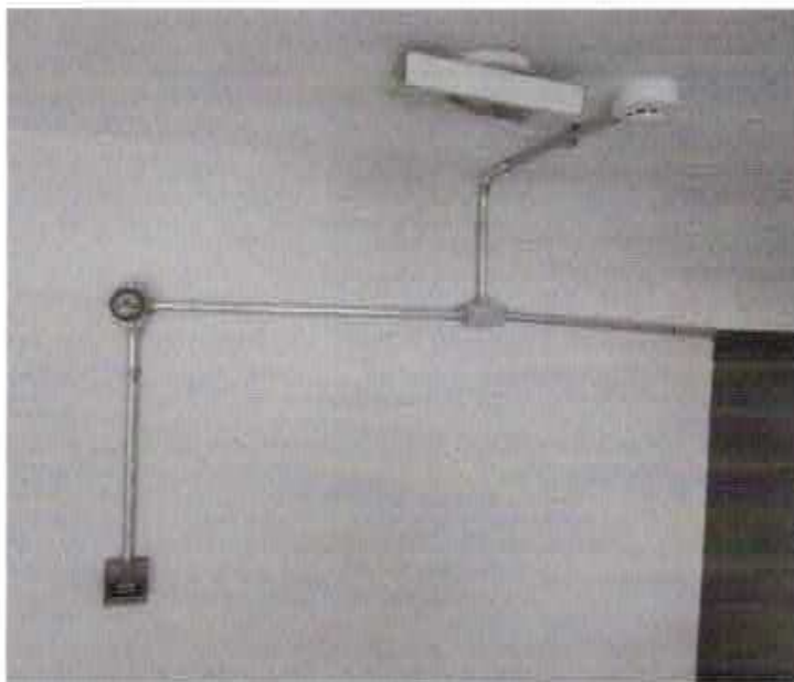
Fig.17 e 18 – Observa-se acima o sensor de 68°C, lâmpada de alarme de incêndio e sensor de fumaça instalados no Teatro 04 de Setembro. Abaixo vê-se indicação de saída de emergência e também a instalação dos equipamentos de combate a incêndio em todos ambientes do prédio.
