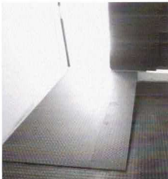
Fig.27 e 28 – Observa-se rampa móvel de acessibilidade na entrada para camarins e abaixo piso com carpete anti-chamas e ao fundo extintor de incêndio.
