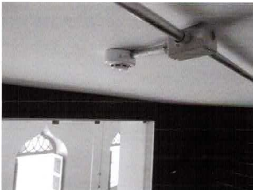
Fig.29 e 30 – Observa-se acima mais um dos sensores instalados no forro do Teatro 04 de Setembro e abaixo as poltronas com estofado anti-chamas no teatro.
