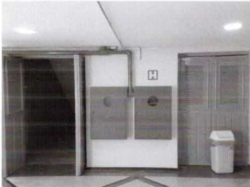
Fig.19 e 20 – Observa-se 02(duas) caixas de hidrantes instaladas no American Bar do teatro e abaixo observa-se sensor de fumaça no forro do camarim.
