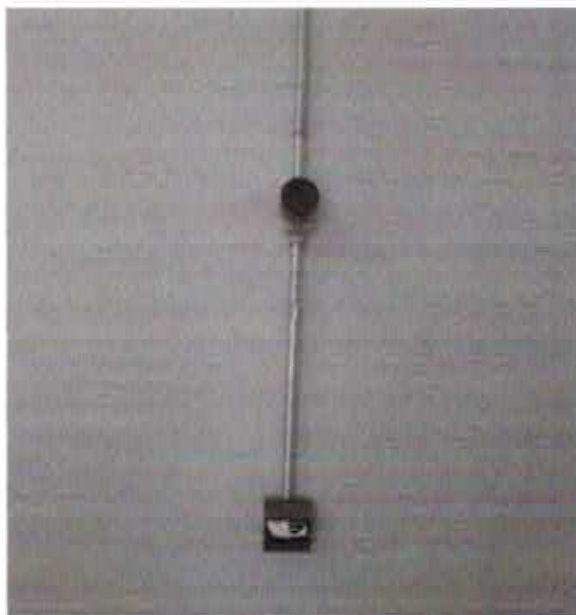
Fig.11 e 12 – Acima observa o sensor de 68°C com acionador quebra-vidro e lâmpada de alarme de incêndio instalados no salão de exposições do Clube dos Diários, e abaixo detalhe do detector de fumaça instalado neste mesmo salão.
